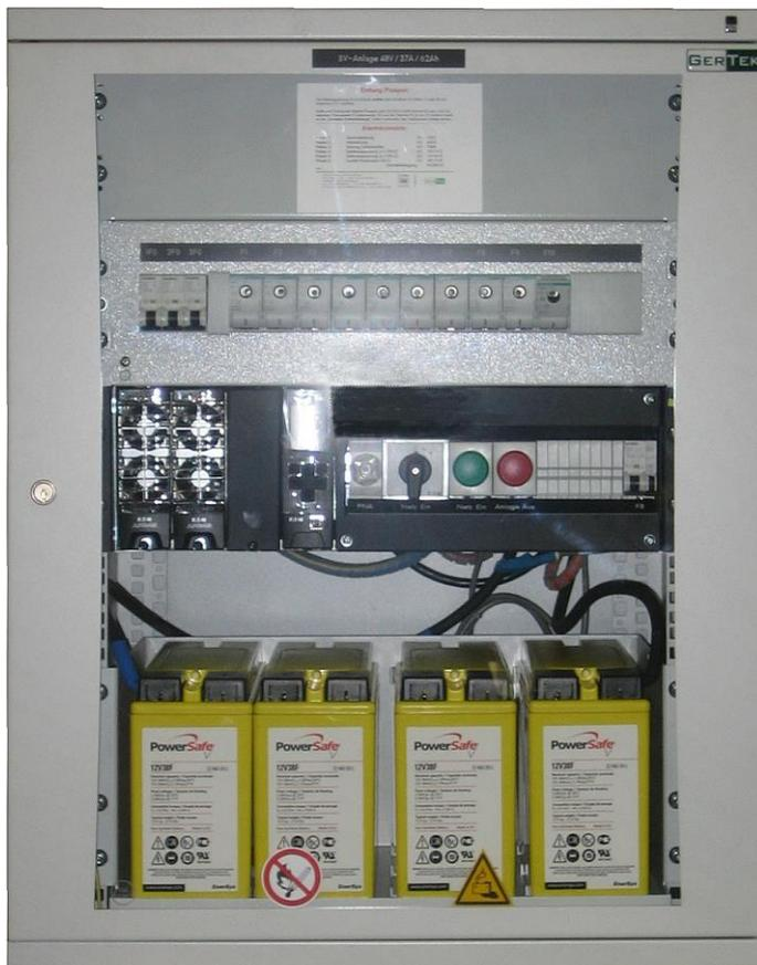
Die Anlage kann steigendem Leistungsbedarf während der Einsatzdauer oder Redundanzanforderungen angepaßt werden. Erweiterungen und Austausch sind ohne Störungen des Betriebs möglich. Module vom Typ APR48-3G können ebenfalls, auch gemischt, verwendet werden - mit verringertem Wirkungsgrad und Leistung.
